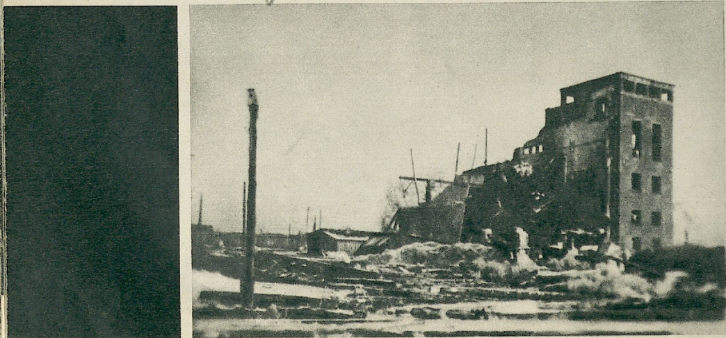
Городская электростанция в гор. Бресте, взорванная немецко-фашистскими захватчиками (см. документ № 129).
