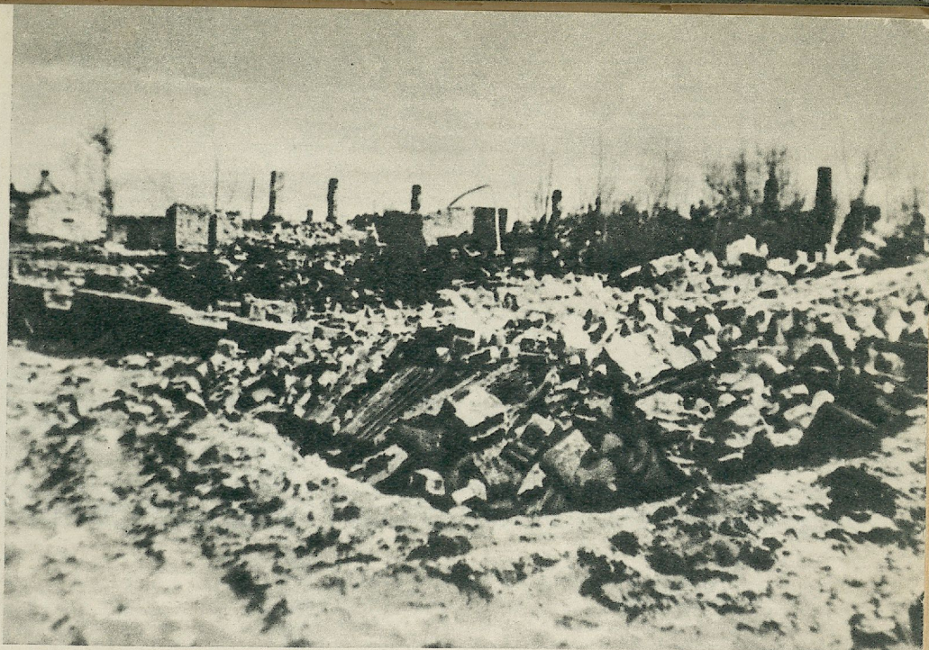
Развалины жилых домов по ул. Пушкина. в гор. Бобруйске.
